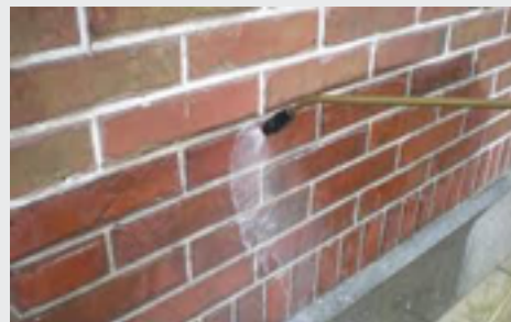
Hydrofoberen van metselwerk
