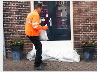
Zandzakken met een houten schot en klei
