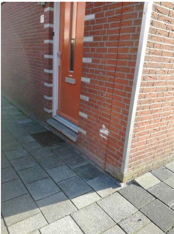
Westzijdse pad (gelegen tussen fase 1 en 2)
