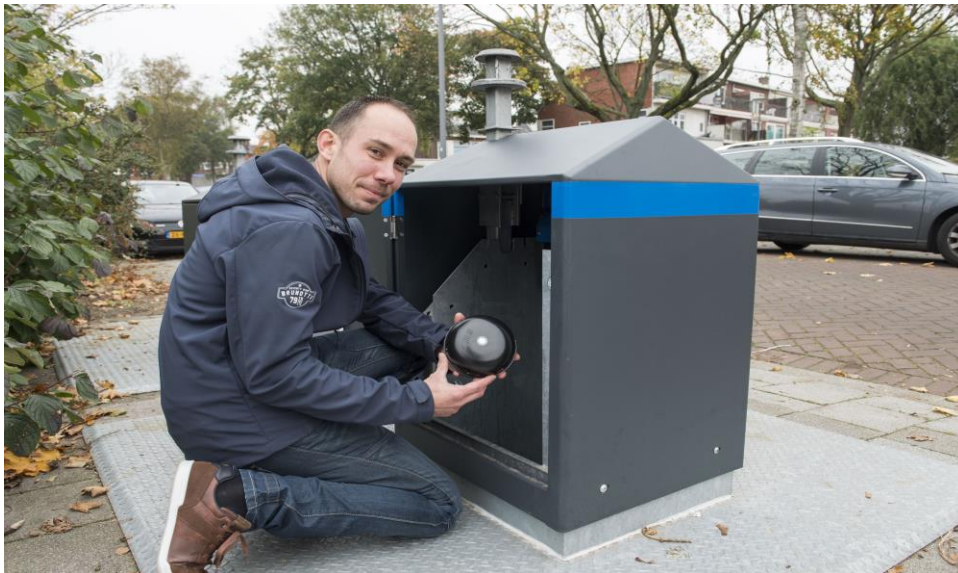
De Rotterdamse afvalcontainers worden fasegewijs voorzien van sensoren
