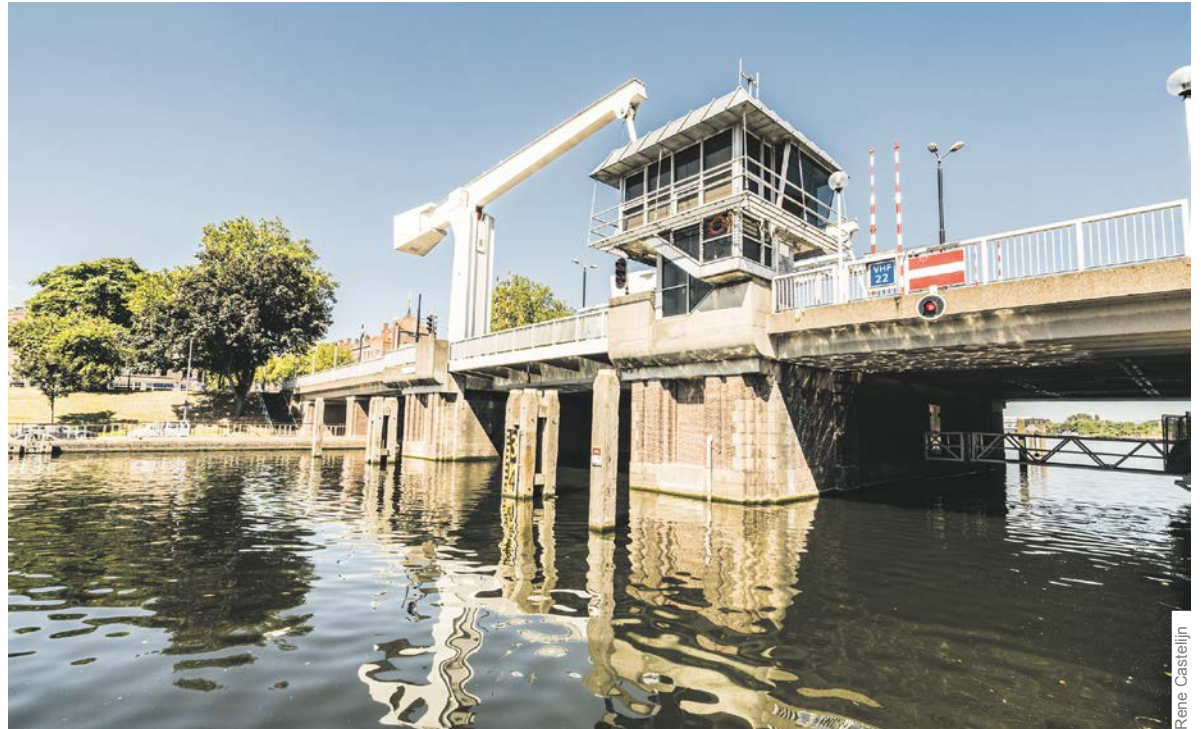
Beweegbare bruggen, zoals de Mathenesserbrug in Delfshaven, worden met water gekoeld. Dat is om te voorkomen dat het metaal uitzet en de bruggen daardoor niet goed meer dichtgaan.
