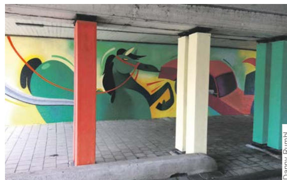
Het eerste tunneltje onder de A13 is in 2017 opgeknapt.
