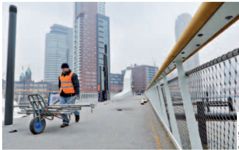
De nieuwe Rijnhavenbrug is vanaf 8 februari in bedrijf. De gemeente was maandag jl. nog druk met werkzaamheden aan de brug.
