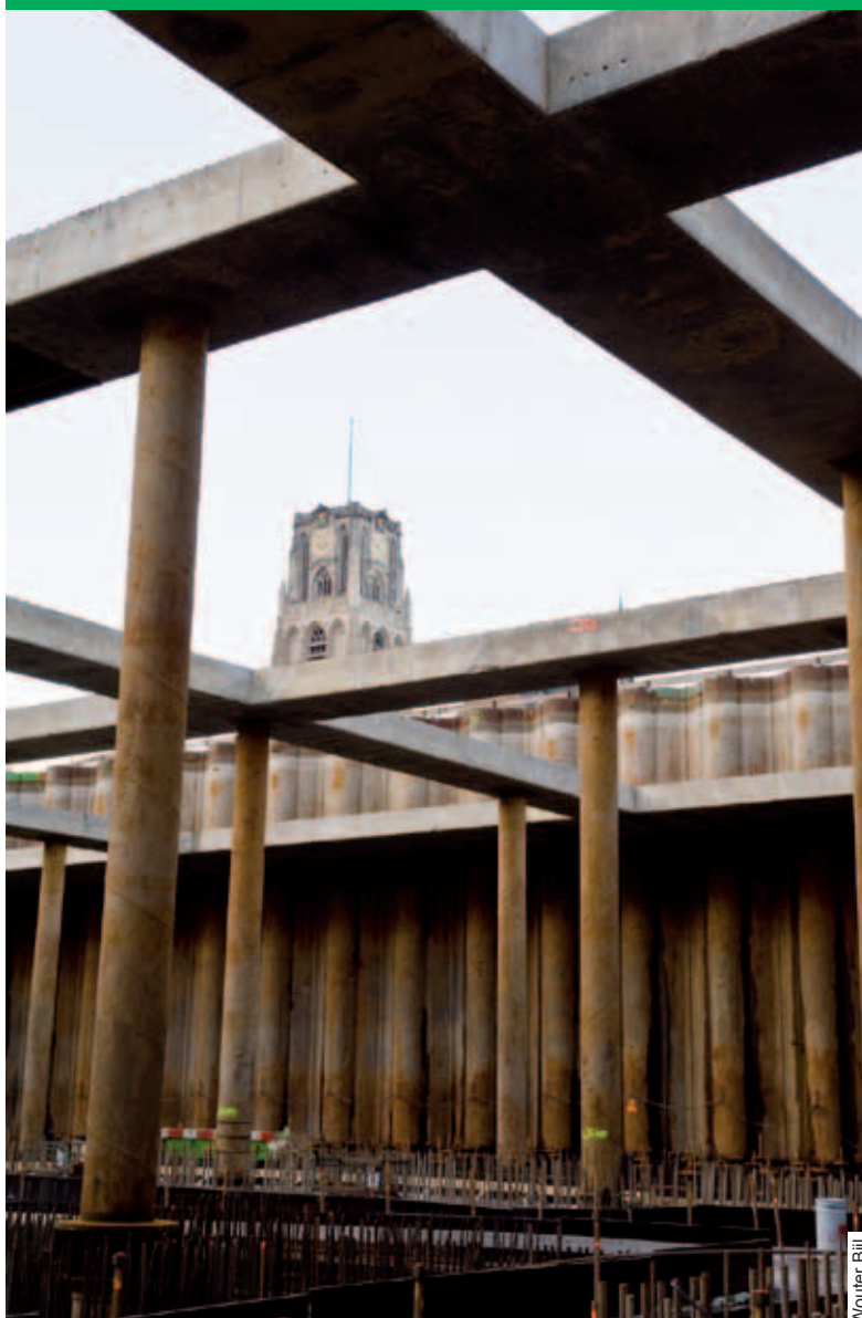
Wouter Bijl over zijn foto: 'Vanaf de bodem van de bouwput van de nieuwe Markthal is het een unieke blik op de Laurenstoren, iets dat niet gauw weer zal voorkomen. Het contrast tussen oud en nieuw is treffend.' Wouter Bijl is cursist bij de SKVR beeldfabriek en laat met deze foto zijn visie op Rotterdam zien.
