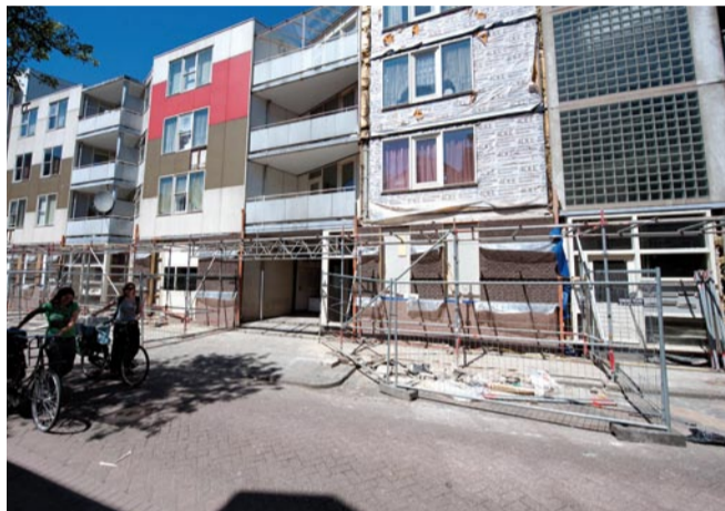
In de Schietbaanstraat zijn de gekleurde trespaplaten van de gevels verwijderd.
