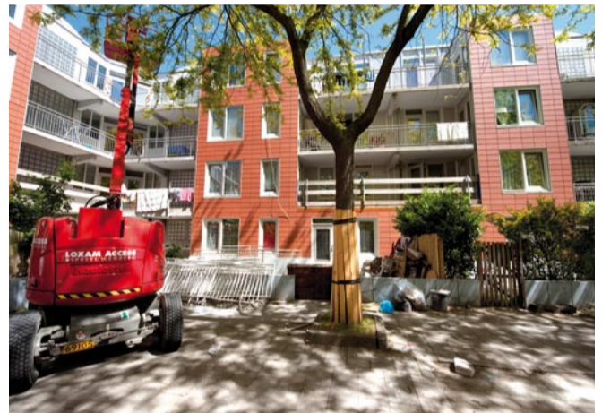
De gevels aan het binnenterrein hebben keramische platen gekregen.
